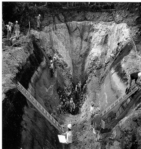
写真2 勝津川断層 野首トレンチの状況(岡田撮影) このトレンチは低断層崖を横切って南北方向に掘削されたために、トレンチ底から段丘面上まで比高約13mもある。日本で行われたトレンチ事例としては最深のもの。写真左右の法面は均配が約45°、その途中には大走りが作られた。
